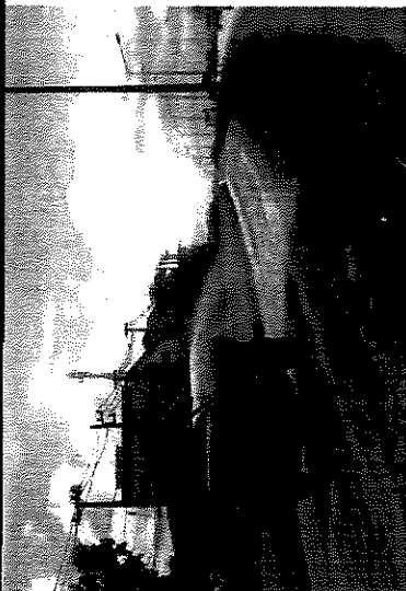
รูปที่ 7 การติดตั้งรั้วชั่วคราว และการฉีดพรมน้ำ เพื่อป้องกันฝุ่นละอองและเสียงจากการก่อสร้าง
